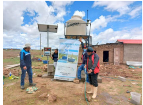
Die Sicherung der Trinkwasserversorgung ist eine wichtige Komponente des Projektes.
